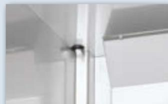
Les appareils sont équipés d'un conduit (diamètre de 7,0 mm) dans le plafond permettant de raccorder un **détecteur de température indépendant**.
